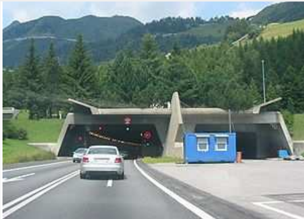
Galleria stradale del San Gottardo
